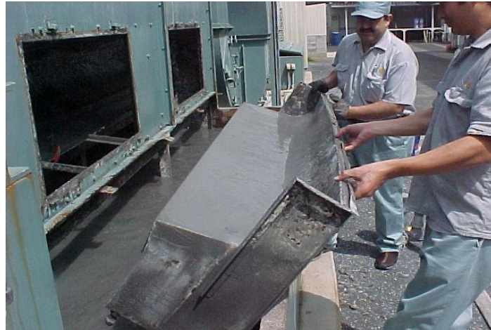
図 9.20 仕切り板等の取り外し作業
