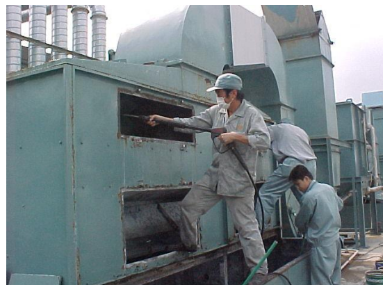
図 9.22 マグネシウム付着剥離作業
